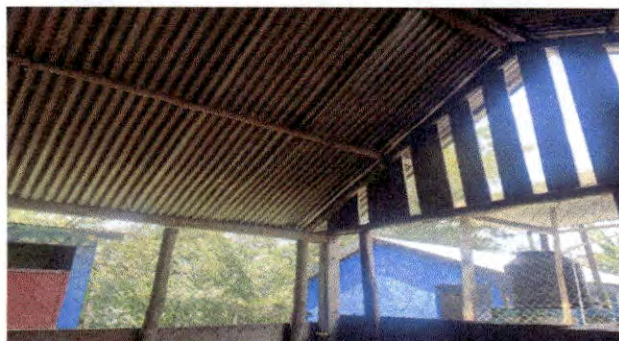
Foto 5: Techo de lamina de cocina en muy mal estado.
