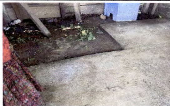
Foto 2: Piso de cocina sin terminar.
