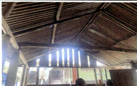
Foto 8: Estructura de madera en interior de cocina.
